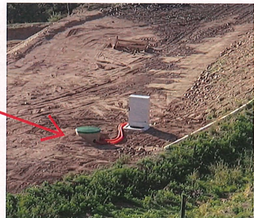
Puits relevage n°2 lagune vers nouveau bassin lixivants site 2
