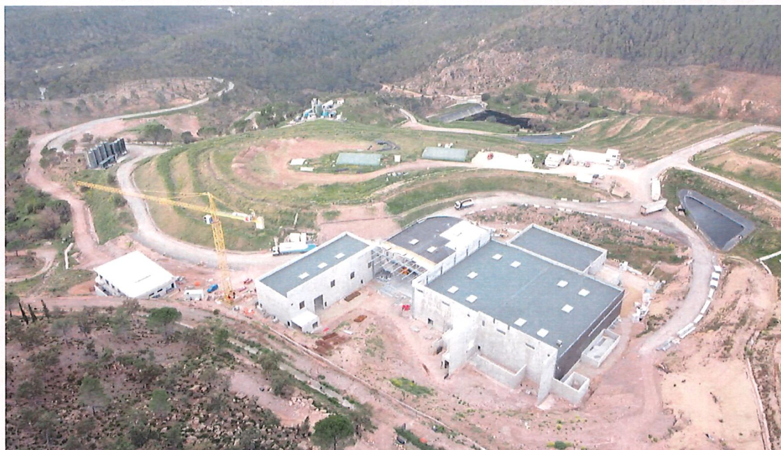
Construction de l'usine de valorisation multifilières – Avril
