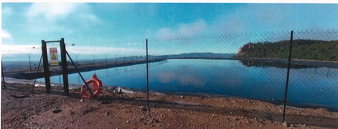
Bassin lixivants site 2 en service
