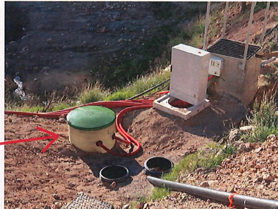
Puits relevage n°1 lagune vers nouveau bassin lixivants site 2
