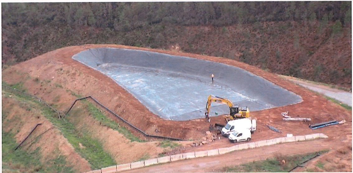
Bassin lixiviats site 2 en construction (géomembrane étanche)
