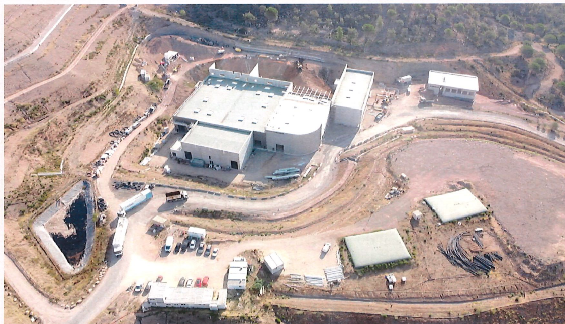
Construction de l'usine de valorisation multifilières – Avril
