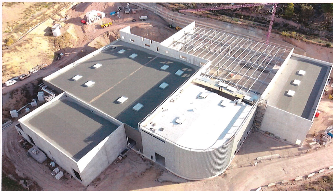
Avancée des travaux – Décembre
