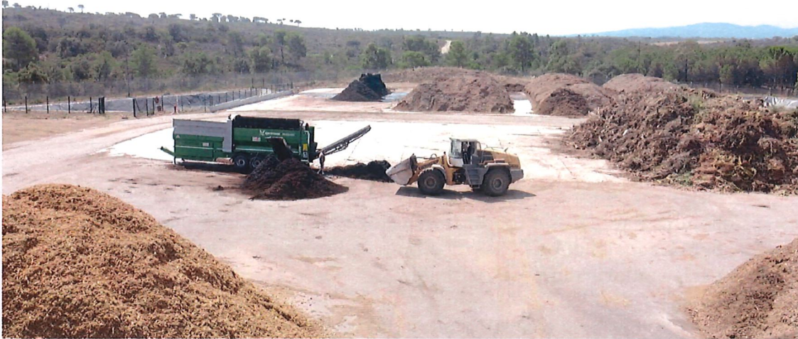
Plateforme de compostage du SMIDDEV à Puget-sur-Argens
