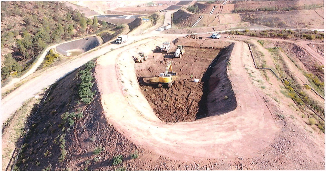
Bassin lixiviats site 2 en construction (argile)
