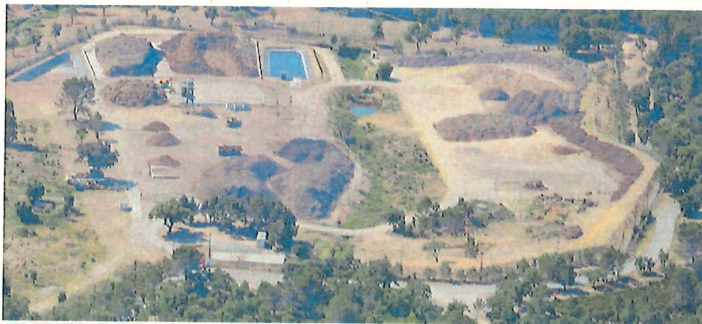
Photo n° 2 : Plateforme de compostage de la Poudrière à Puget-sur-Argens
