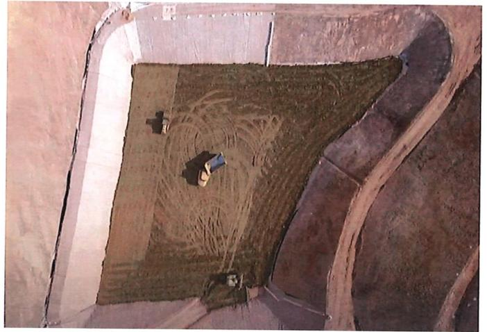
Figure 9 : Mise en forme du casier
