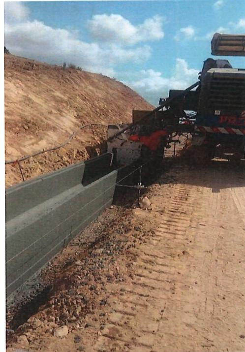
Figure 10 : Caniveaux coulés en place
