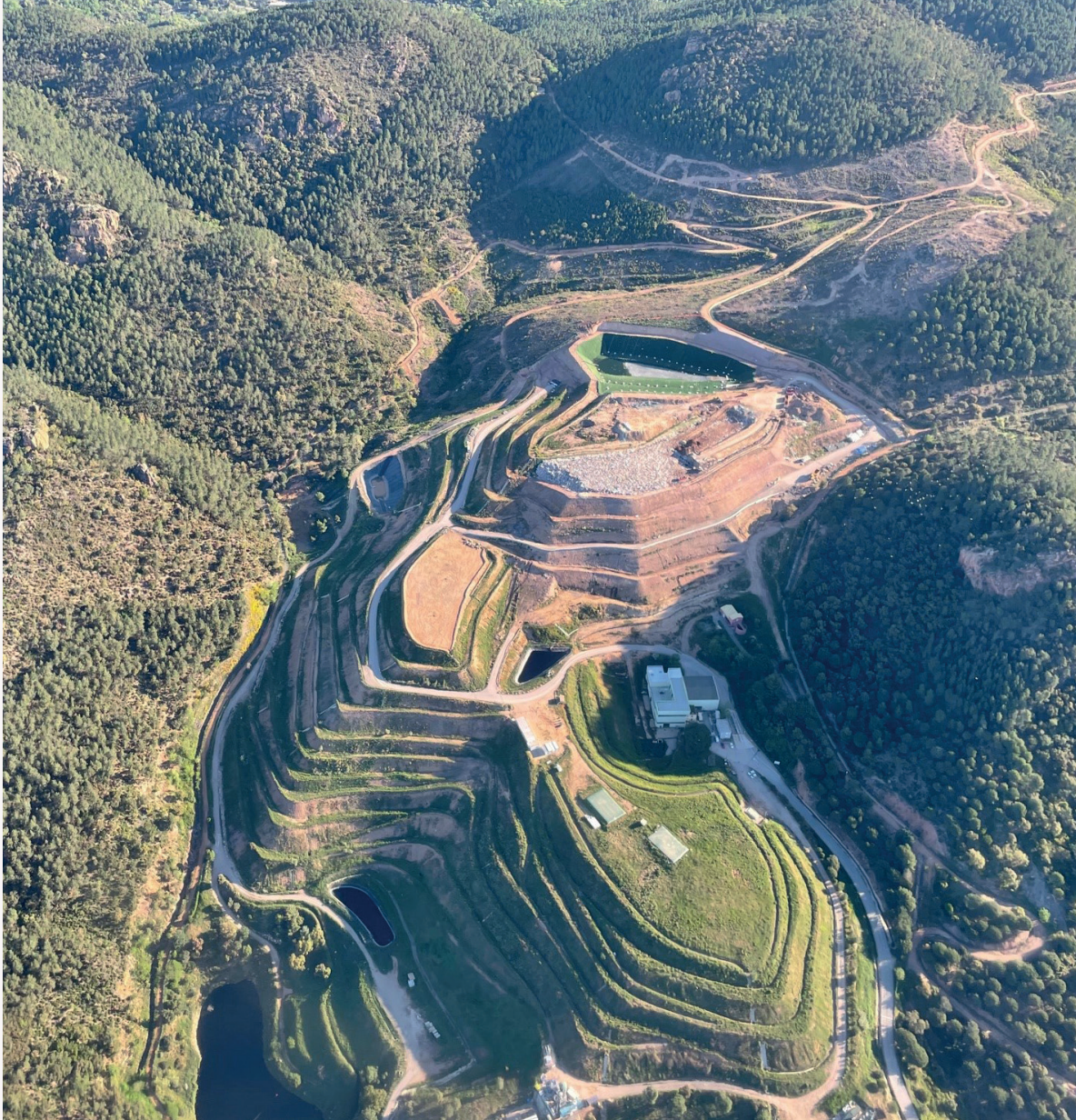
Vue aérienne de l'ISDND – Mai 2021
