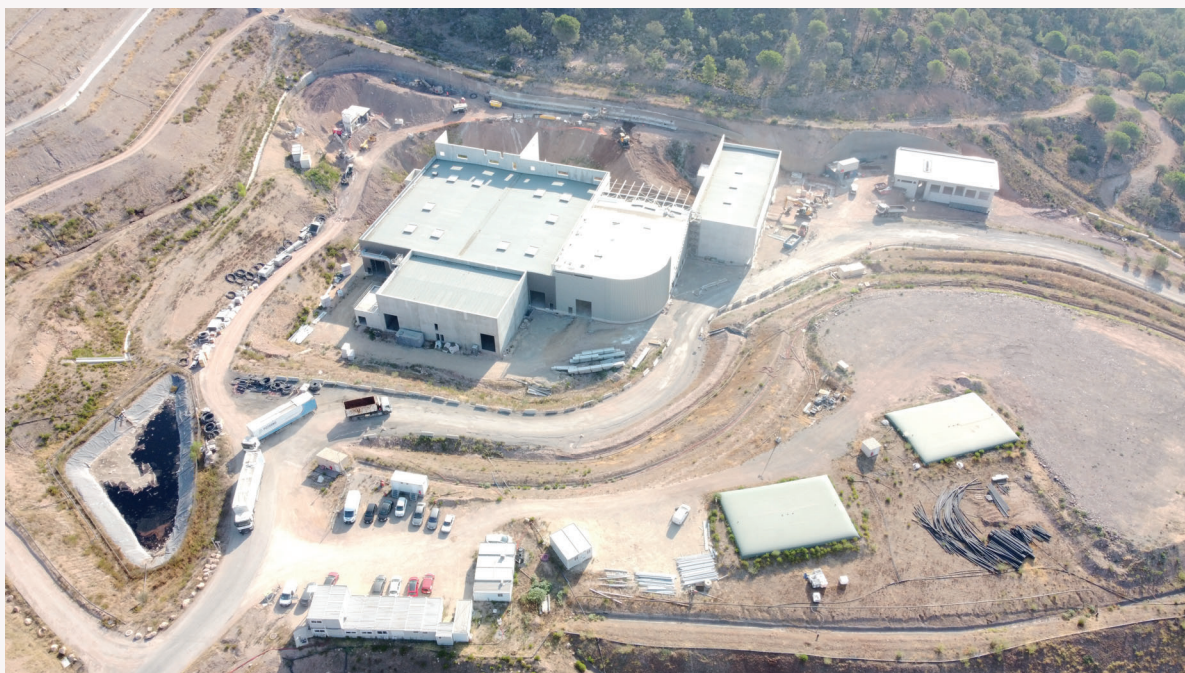
Construction de l'usine de valorisation multifilières – Avril
