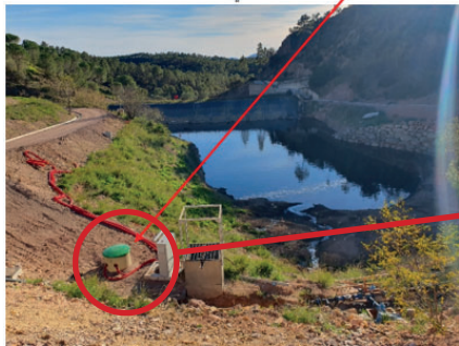
Puits relevage n°1 lagune vers nouveau bassin lixiviats site 2
