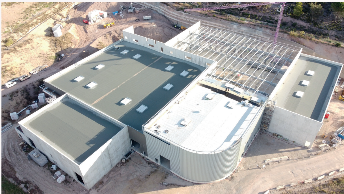
Avancée des travaux – Décembre
