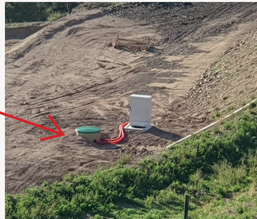
Puits relevage n°2 lagune vers nouveau bassin lixiviats site 2
