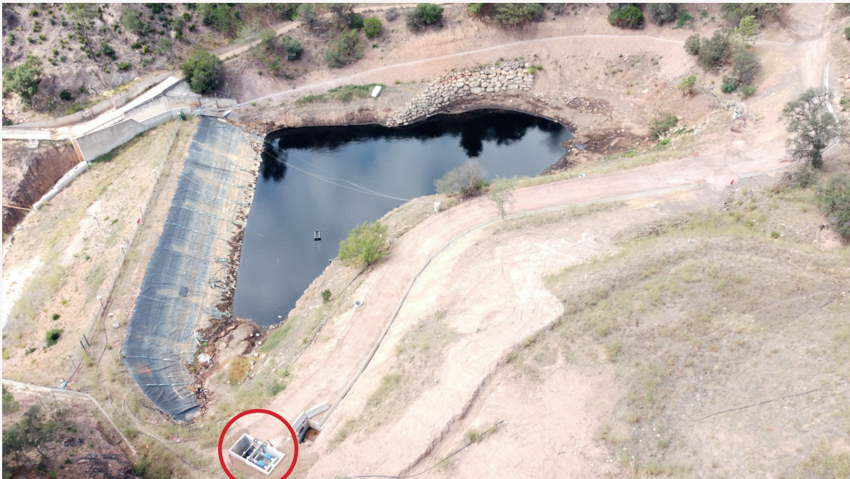
Caniveaux périphériques lagune
