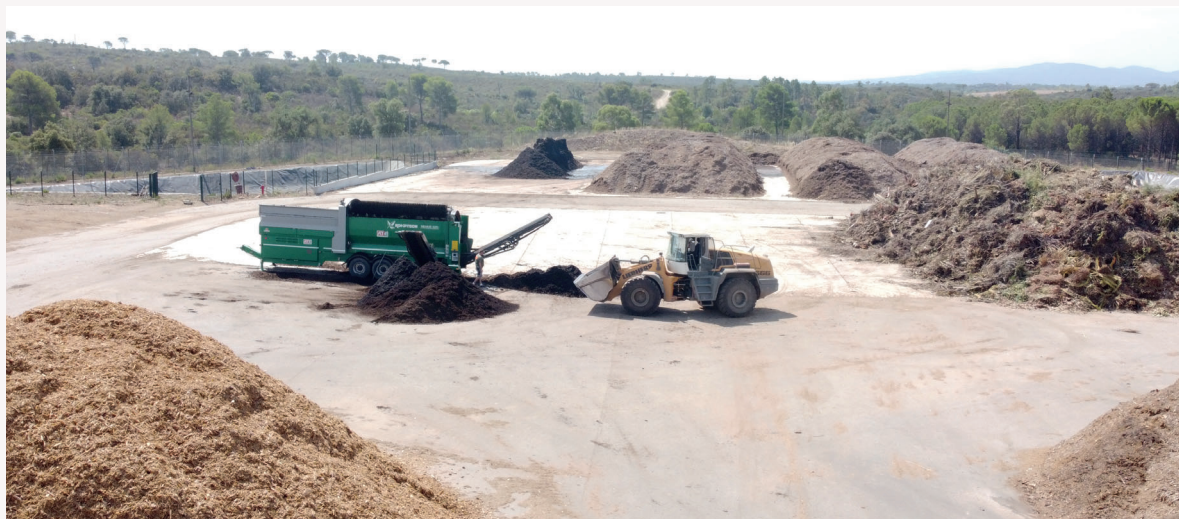
Plateforme de compostage du SMIDDEV à Puget-sur-Argens
