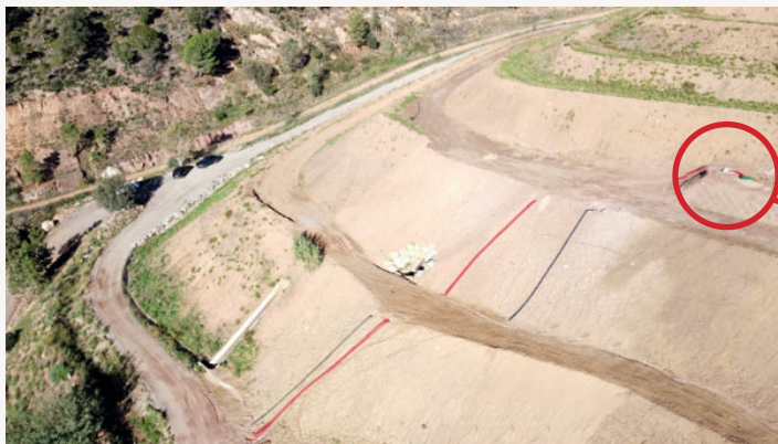
Puits relevage n°2 lagune vers nouveau bassin lixiviats site 2
