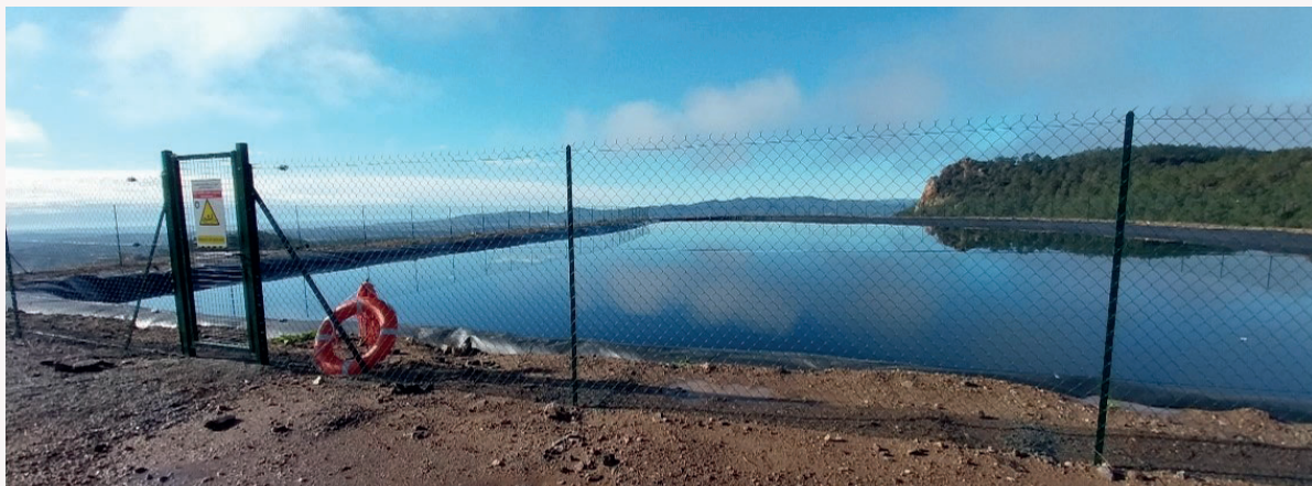
Bassin lixiviats site 2 en service
