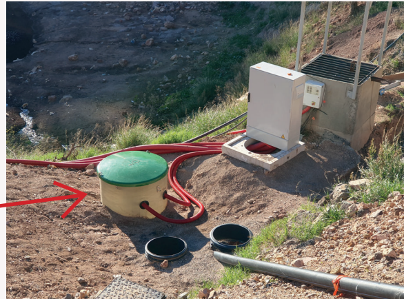
Puits relevage n°1 lagune vers nouveau bassin lixiviats site 2
