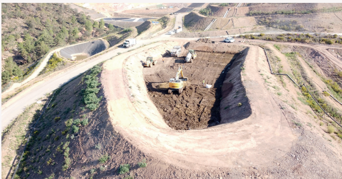
Bassin lixiviats site 2 en construction (argile)
