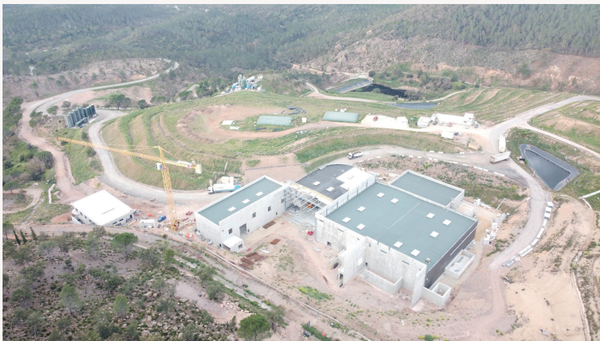
Construction de l'usine de valorisation multifilières – Avril
