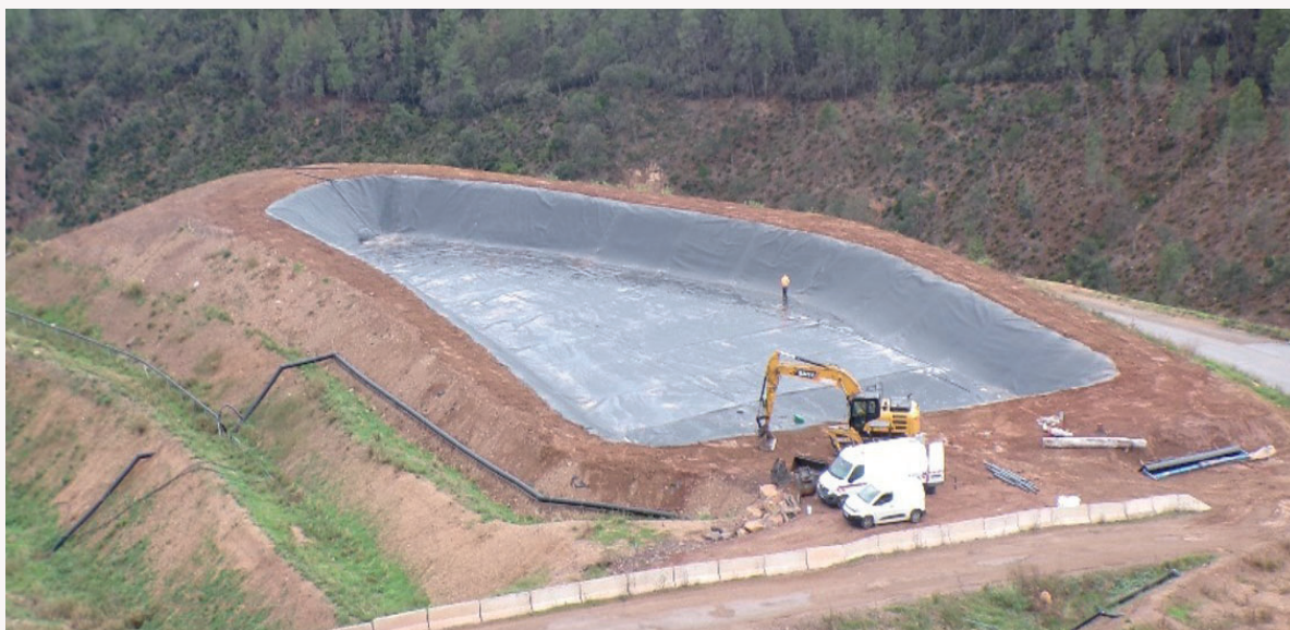
Bassin lixiviats site 2 en construction (géomembrane étanche)
