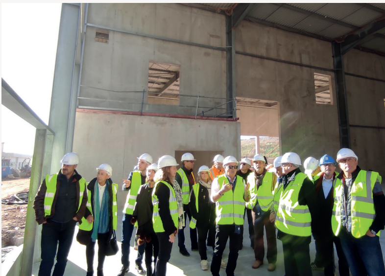
Visite du chantier de l'UVM avec les membres élus du Conseil Syndical du SMiDDEV Décembre
