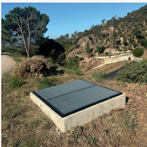
*Un caillebotis a été positionné sur le regard de rejet des eaux pluviales de la lagune, à proximité de la plateforme du bassin tampon.*
